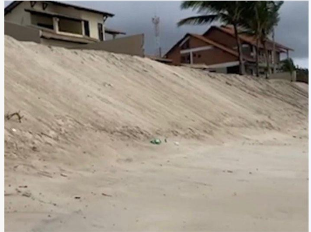
Após a obra
